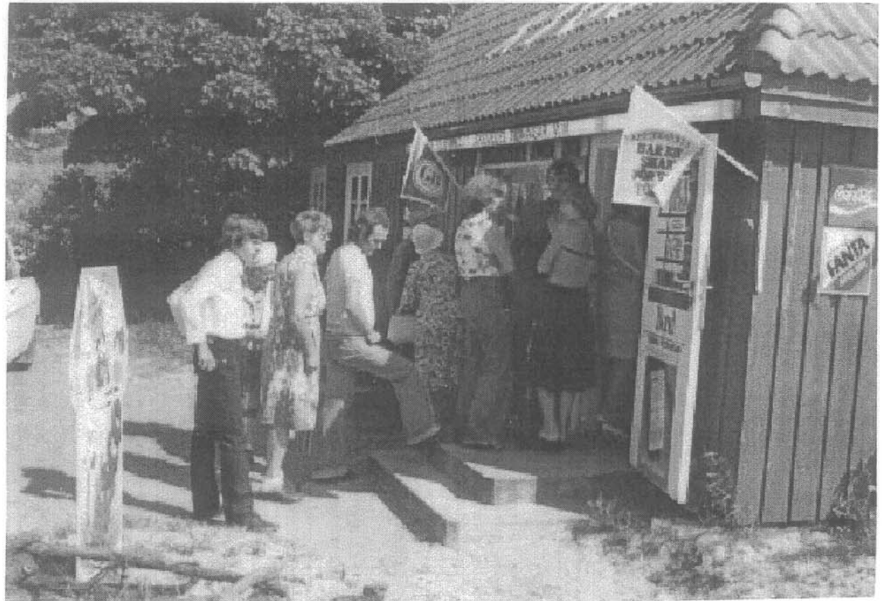
36. Kiosk på taket år 1976
